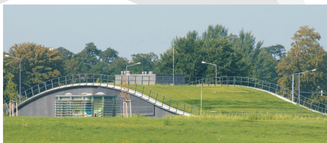
Hochwasserpumpwerk Dresden-Johannstadt (Foto: Stadtentwässerung Dresden GmbH)
